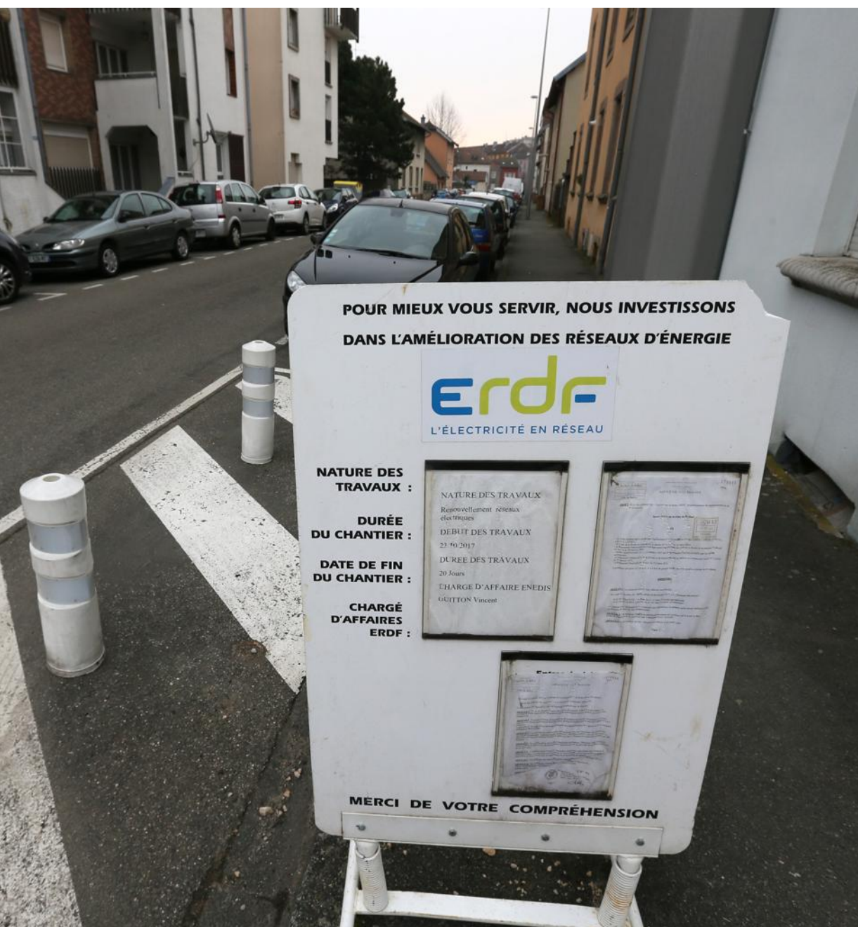
Des travaux d'installation de compteurs Linky sont en cours, rue Jules-Ferry. Photo Christine DUMAS
